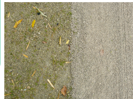
AVANT - APRÈS Désherbage mécanique de stabilisé
